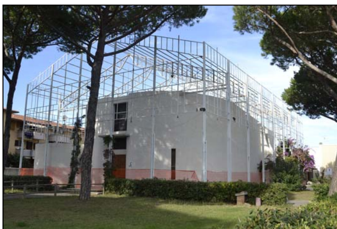
Fig.3_Chiesa di Santa Maria Goretti dopo la rimozione dei pannelli di copertura in eternit
