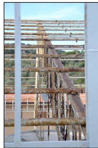
Fig.5_Dettaglio della struttura di copertura in metallo
