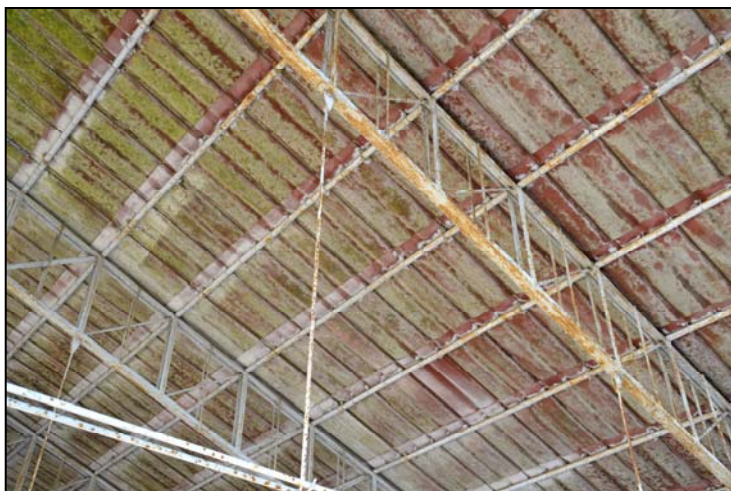
Fig.4_Lastre di copertura in eternit prima della rimozione
