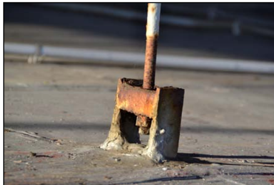
Fig.7_Dettaglio del tirante di copertura
