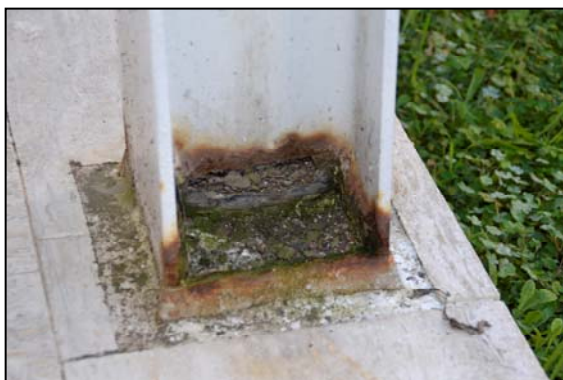
Fig.6_Dettaglio del piede dei montanti della struttura di sostegno delle coperture
